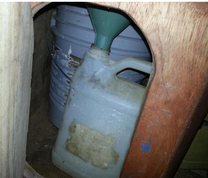
**Vue rapprochée des TSLB** : coffre en bois, réserve de litière, papier toilette, abattant du commerce, seau de 20 litres avec couvercle, ½ entonnoir pour la séparation des urines, petit bidon de récupération de celles-ci (usage d'engrais après dilution 1/10 pour le jardinage), dispositif de lavage des mains (tube de perfusion avec molette)
