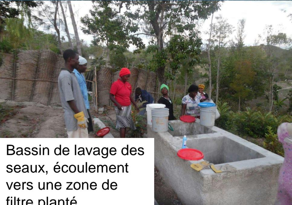
Bassin de lavage des seaux, écoulement vers une zone de filtre planté
